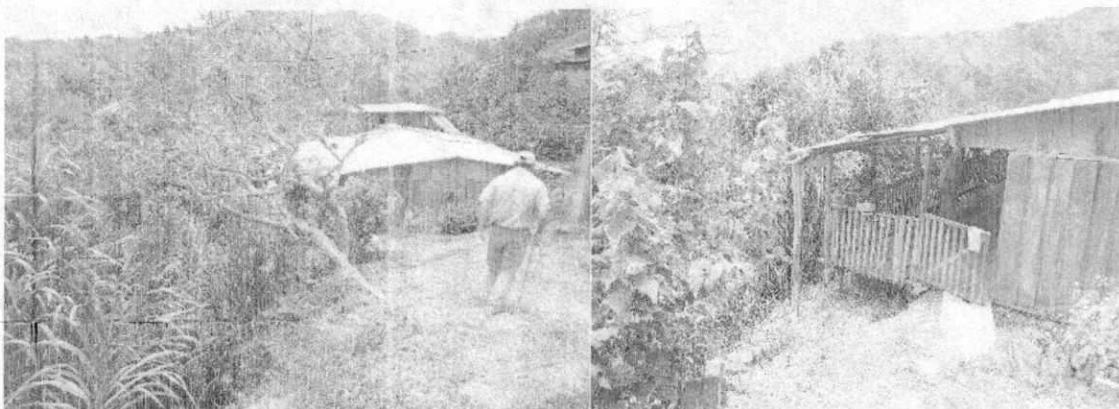
Otra vivienda que por la acción de las aguas lluvias también necesita intervención
