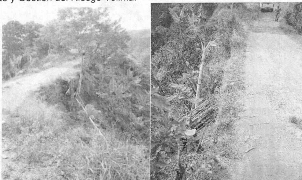
Terraplén construido en Ko+5.0 km vía que conduce a las Veredas Guali y El Águila
