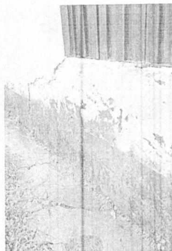
Foto 14 y 15 Muros fachada posterior con fisuras.
