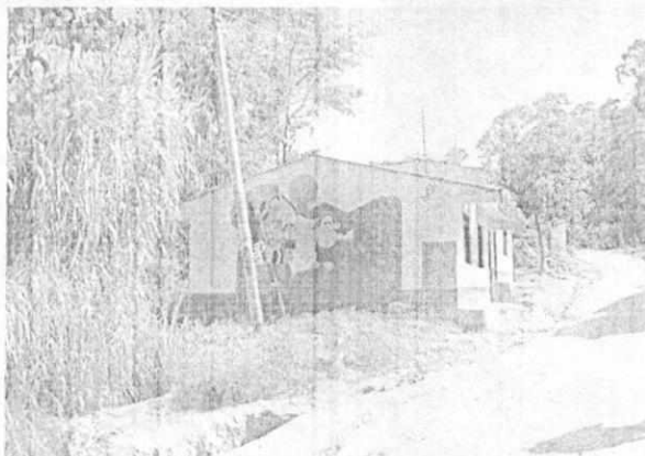
Foto 9. Foto tomada en 2014 en la cual se ve que no se tenía manejo de agua lluvias
